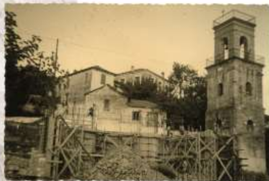
Εργασίες για την ανέγερση του νέου ναού. Πολλοί κάτοικοι του χωριού εργάστηκαν εκεί εθελοντικά
