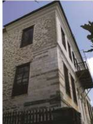
Οικία Μίλλερ. Διακρίνεται το πρωτόωο με το τρίλοβο τόξο και η ποιότητα της κατασκευής.
