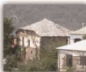
Οικία Ζαρίφη. Διακρίνονται οι δοκοθήκες από το ξώστεγο, η αρχική πόρτα και η μεταγενέστερη που οδηγούσαν σε αυτό.
